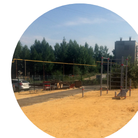
Реконструкция дворовой территории 2020
