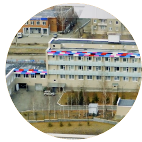
Капитальный ремонт профилактория «Синегорье» 2017
