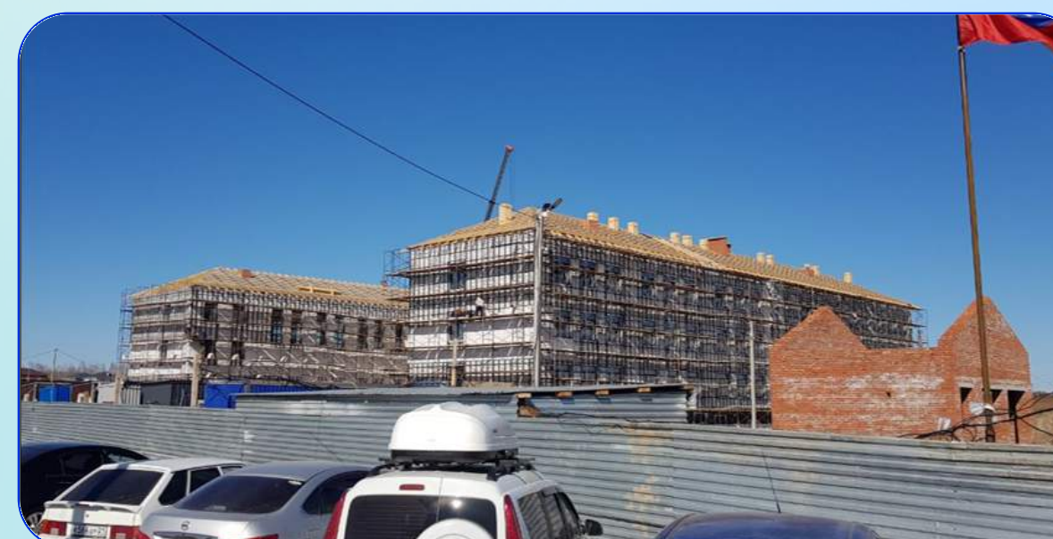
Строительство СОШ на 500 мест Арский муниципальный район
