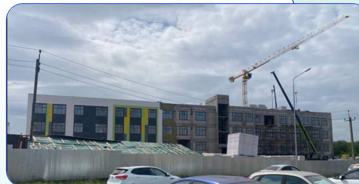
Строительство СОШ на 1501 место, г. Набережные Челны, ЖК «Притяжение»
